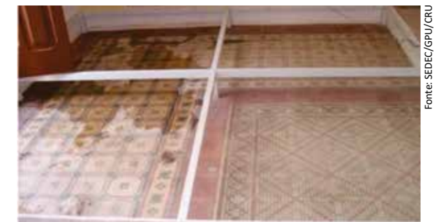
Obra para preservação do piso original, em ladrilho hidráulico encontrado durante a obra (2011)
