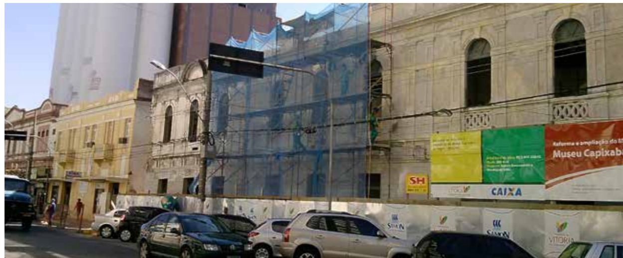
Fachada do prédio do Mucane em reforma (2011)
